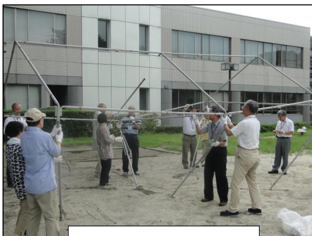
支柱を立てて
