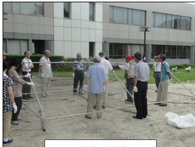
屋根部分完成
